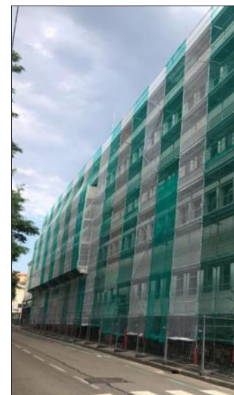
Pour Didier Brosse, le chantier de rénovation de la maison du BTP, sise rue de L'Apprentissage à Saint-Etienne, est l'un des enjeux de son mandat. Photo Progrès/DR
