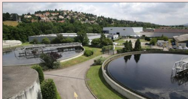
La station d'épuration de Saint-Chamond. Photo Progrès/H.Genouilhac
